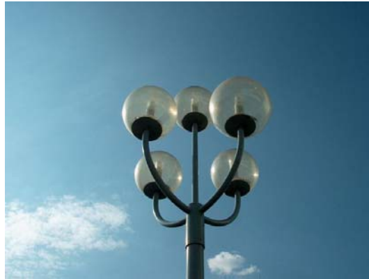
Abbildung 9: Ausseraumleuchte ohne Abschirmung und mit hohem Lichtenergieverlustanteil
